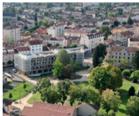
À la Madeleine, l'immeuble Cardinal s'ouvre sur le parc.
