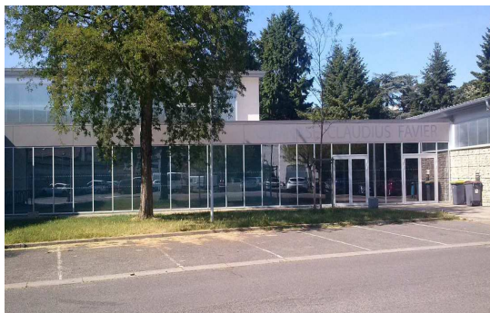
Gymnase FAVIER : Travaux de d'économie d'énergie intégrant la mise aux normes accessibilité complète du bâtiment.
