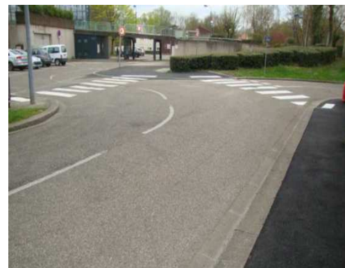
Allée du Moulin de Brou : mise aux normes et création de passages-piétons pour sécuriser les déplacements de riverains, notamment déficients visuels
