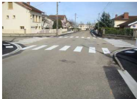
Rue Félicien PROUST : réfection couche de surface des accotements et création de 4 passages piétons
