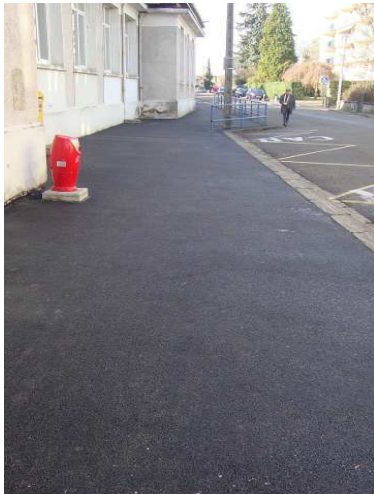
Rue Comte de la Teyssonnière - de la crèche au passage de l'école du Peloux : réfection du revêtement, mise aux normes du GIC pour améliorer et sécuriser les déplacements aux abords de l'école, notamment d'un riverain se déplaçant en fauteuil. Travaux en cohérence avec la mise aux normes de l'école du Peloux et du PAVE.
