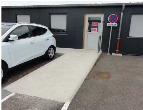
Centre Technique Municipal (CTM) : Bâtiment Code du travail mais réalisation de travaux d'accessibilité avec aménagement d'un GIC et d'une rampe d'accès aux bureaux recevant du public .
