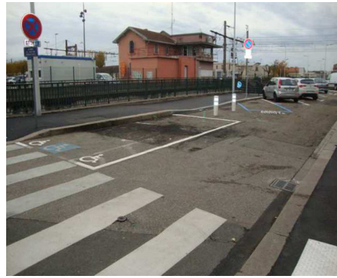
Avenue des Anciens Combattants : mise aux normes du GIC (élargissement et marquages au sol) à l'occasion de la réfection du revêtement
