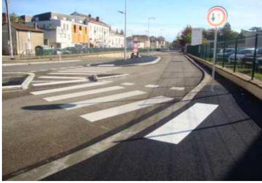
Avenue du Mail - voie d'accès à la rue du Peloux : élargissement du trottoir pour mises aux normes et création d'un passage-piétons
