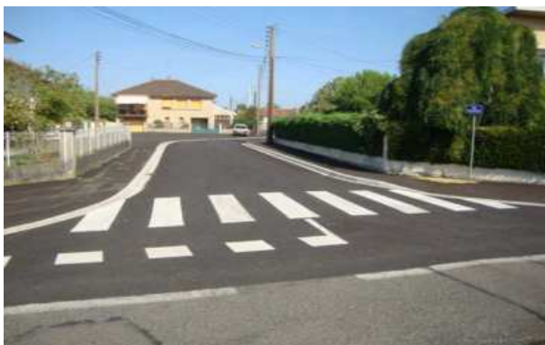
Rue DESCARTES : réfection et élargissement ponctuel des trottoirs pour mise aux normes PMR + création de 2 passages-piétons
