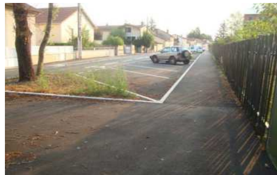
Rue des GRAVES - section rue du Stand à Lazare Carnot : élargissement du cheminement piéton côté impair, création d'un trottoir côté pair et d'un passage-piétons.
