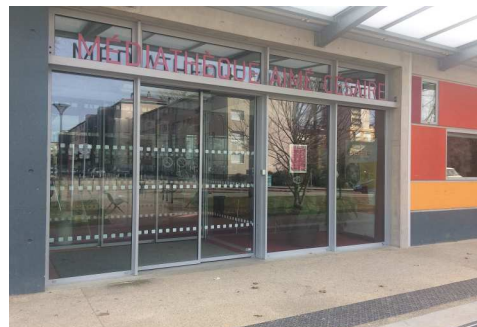
Médiathèque CESAIRE : mise aux normes du cheminement extérieur, des accès (réalisation de chanfreins) et des sanitaires existants, signalétique sur portes vitrées
