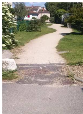
Allée de la NOUBA : suppression partielle d'une bordure et réfection du revêtement à hauteur d'un tampon
