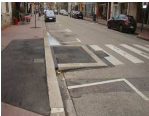
Av. A BAUDIN : création d'une oreille pour améliorer la visibilité de la traversée
