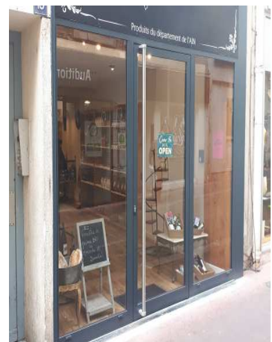
Mise aux normes de la porte d'entrée (élargissement) d'un commerce alimentaire
