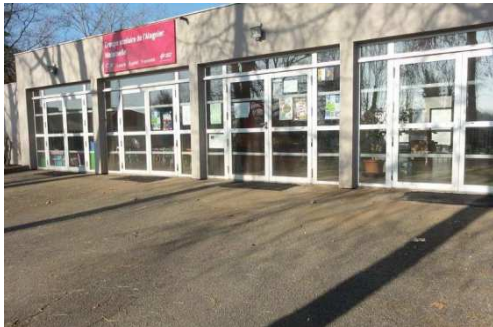
GS ALAGNIER maternelle : mise aux normes des portes intérieures et du cheminement
