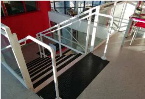
Médiathèque VAILAND : mise aux normes des escaliers et des sanitaires
