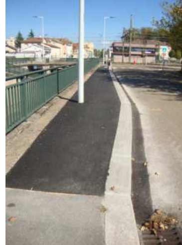
Avenue du Mail - voie d'accès à la rue du Peloux : élargissement du trottoir pour mises aux normes et création d'un passage-piétons
