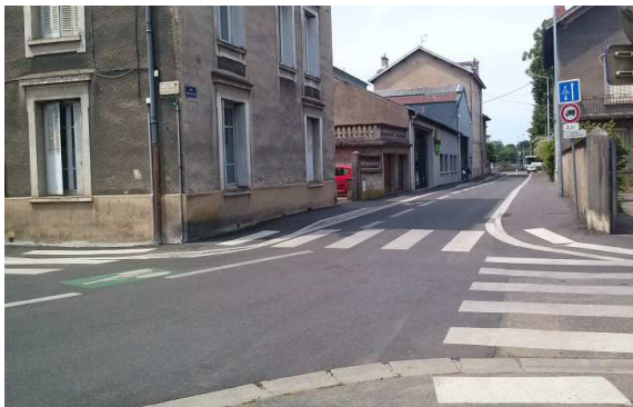
Rue LARGILLIERE : réaménagement complet avec élargissement des trottoirs, création et mise aux normes des passage-piétons et du GIC existant.
