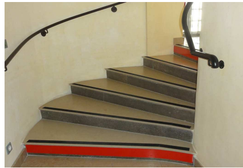
H2M, salles d'expositions et de conférence : mise aux normes des escaliers, aménagement d'une balise sonore à l'entrée du bâtiment et des sanitaires
